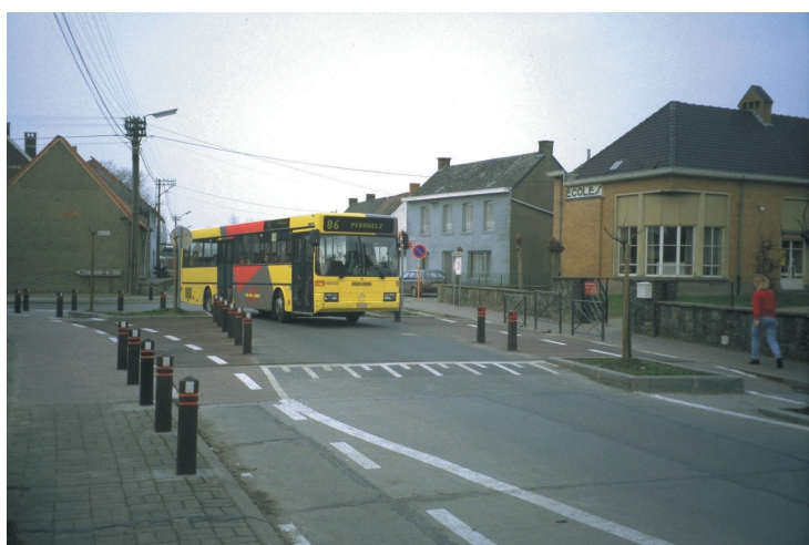
Un plateau «bus admis» et un «by-pass» qui protège les cyclistes des virages à la corde. © IBSR
