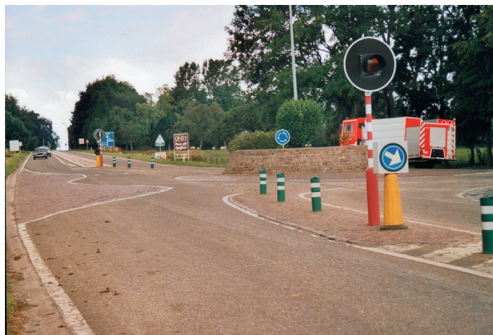
Une effet de portes bien marqué à l'entrée du village de Ohey sur la N 921. L'aménagement tient compte de l'espace nécessaire au passage d'engins agricoles.
