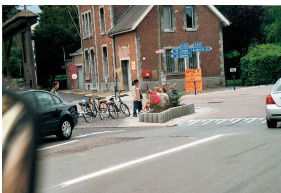
Traversée du village de Ohey par les nationales N 921 et N 698. Les usagers doux ont de l'espace, le plateau ralentit effectivement le trafic.
