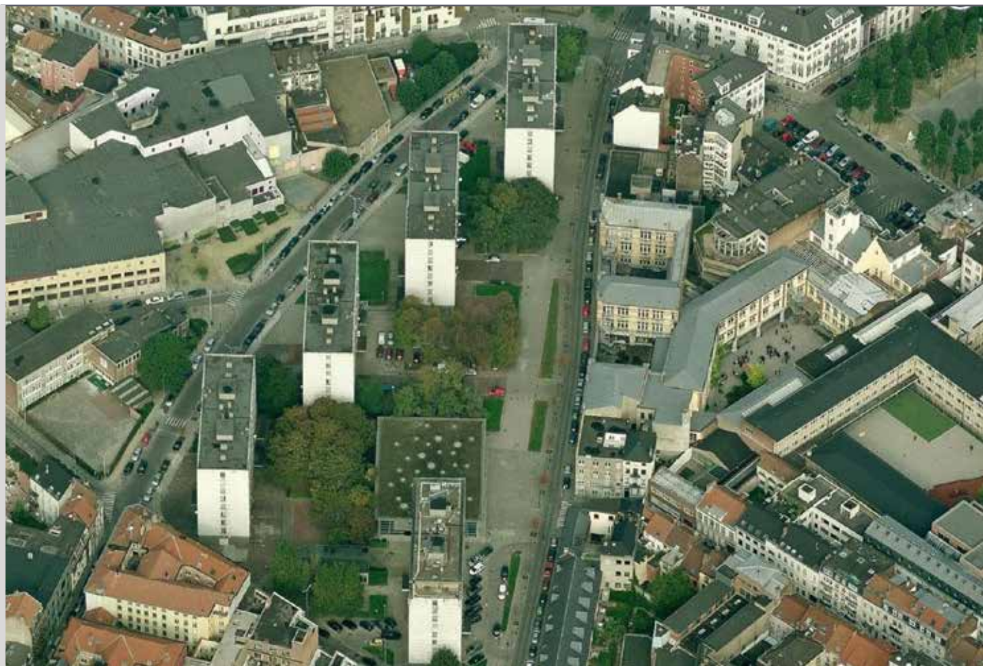
Immeubles d'habitation « tout en façades », tout en avant - avant affaibli par défaut d'arrière. Toutes choses égales par ailleurs, l'absence d'arrière et l'absence de matérialisation des limites entre public et privé réduisent les chances d'appropriation des espaces extérieurs au pied des immeubles. Document Pierre Vanderstraeten.
